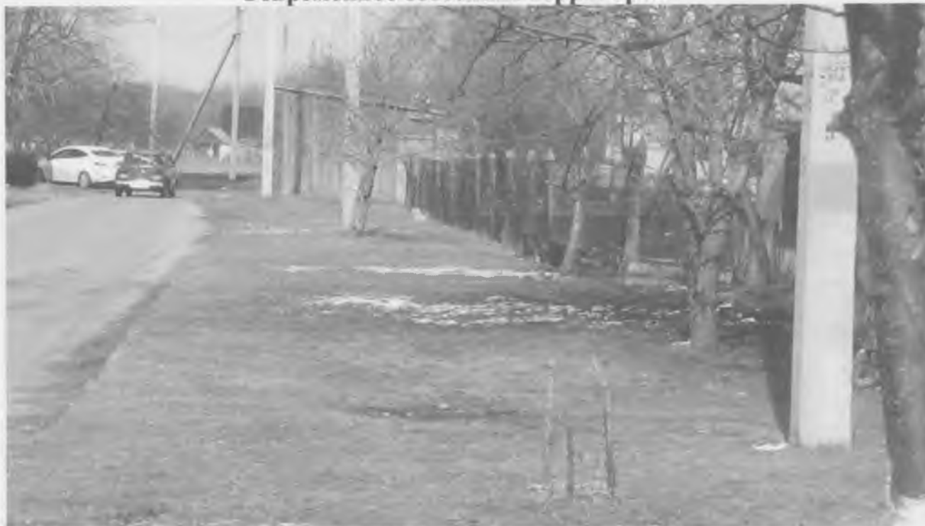
Рис.1. Состояние территории благоустройства.
